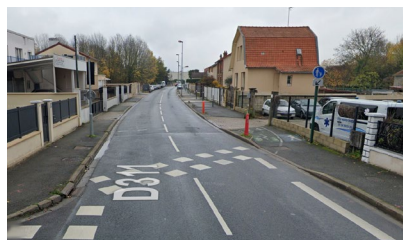
Rue Maurice Berteaux (source : google street view)
