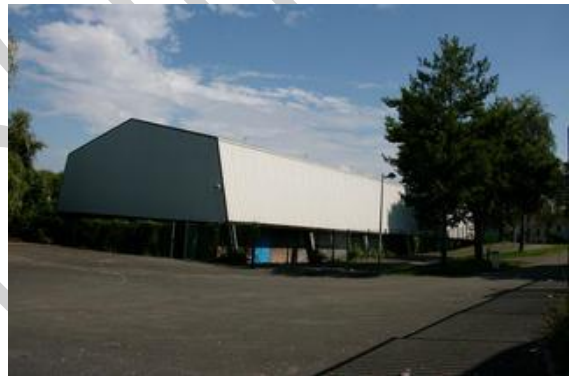
Gymnase du Rouillon (source : villedemontmagny.fr)
