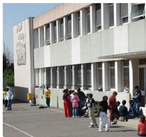
Groupe scolaire Les Lévrieris (source : villedemontmagny.fr)
