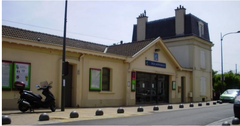
La gare de Deuil-Montmagny (Source : google street view)
