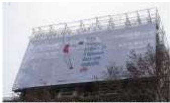
Publicité sur bâche de chantier
