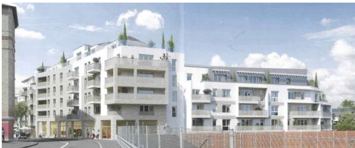
Figure 38 : Vue façade Sud et Est depuis le pont surplombant les voies de tramway
